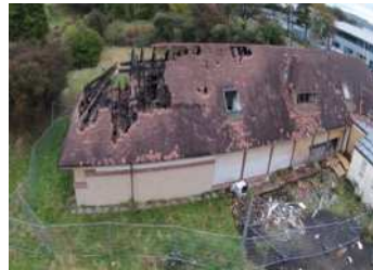
Drohnen für Schadensfeststellung
